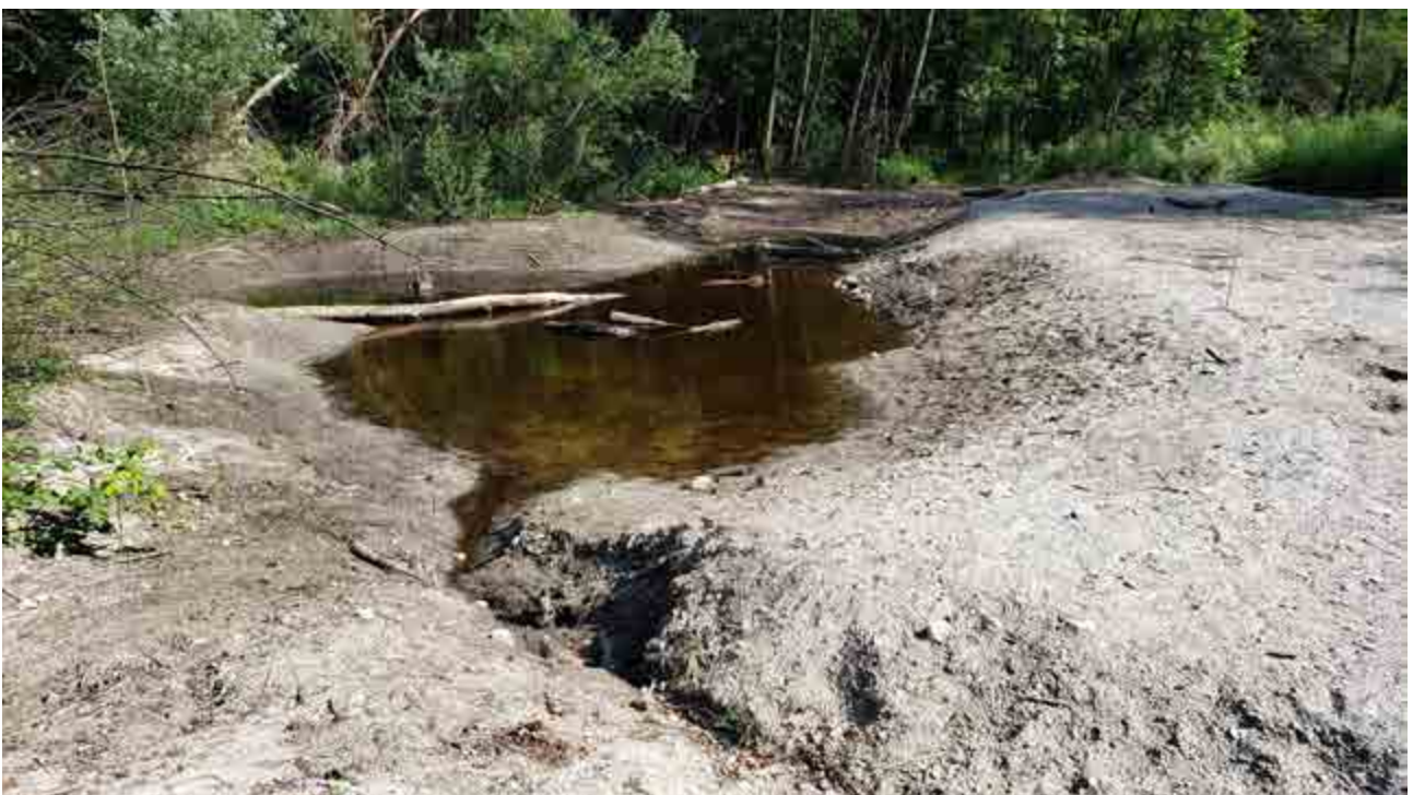
Foto 3: stagno inferiore subito dopo lo scavo
