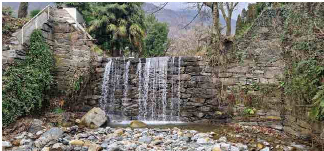
Foto 1: briglia in muratura a monte della zona di deposito
