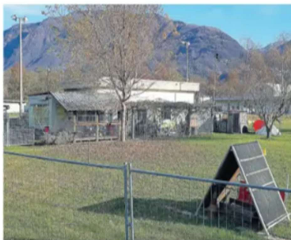
Sopra la vecchia sede da smantellare, sotto il terreno alternativo individuato
