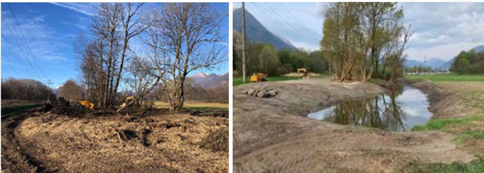
Lanca Isoletta Settore A prima (febbraio 2023) e dopo (agosto 2023) gli interventi © foto EcoControl e Fondazione Parco.
